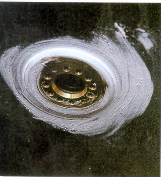
Med hullsag og Sikaflex gikk det lett å montere skroggjennomføringen.
