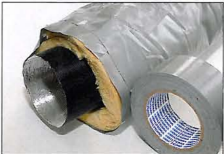
SPLITT OG LIM: Dersom varmluftslangen allerede er lagt kan det mange steder være vanskelig å trø isolasjonsstrømpen utenpå dem. Dette kan løses ved at man klipper opp strømpen, legger den rundt luftslangen og teiper sammen med sølvtteip/vevtteip (Duct-tape).
