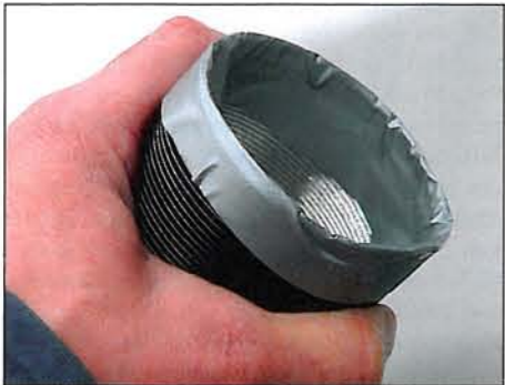
TEIP: Om man ikke har en stuss på enden av røret hjelper det om man teiper enden, slik at det ikke er skarpe kanter som henger seg opp i isolasjonsmateriale. Da er det lettere å trø luftslangen gjennom isolasjonsstrømpen.
